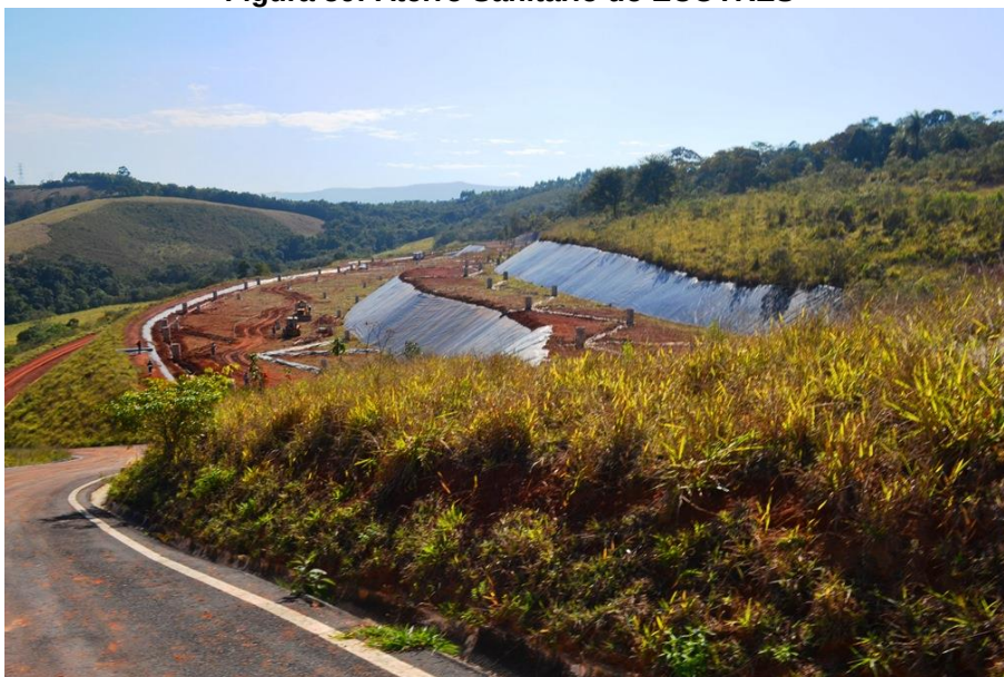
Figura 59: Aterro Sanitário do ECOTRES
