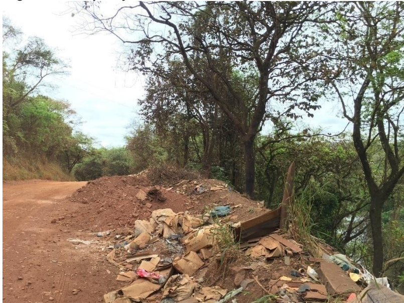
Figura 63: Disposição de RCC às Margens de Estradas Vicinais
