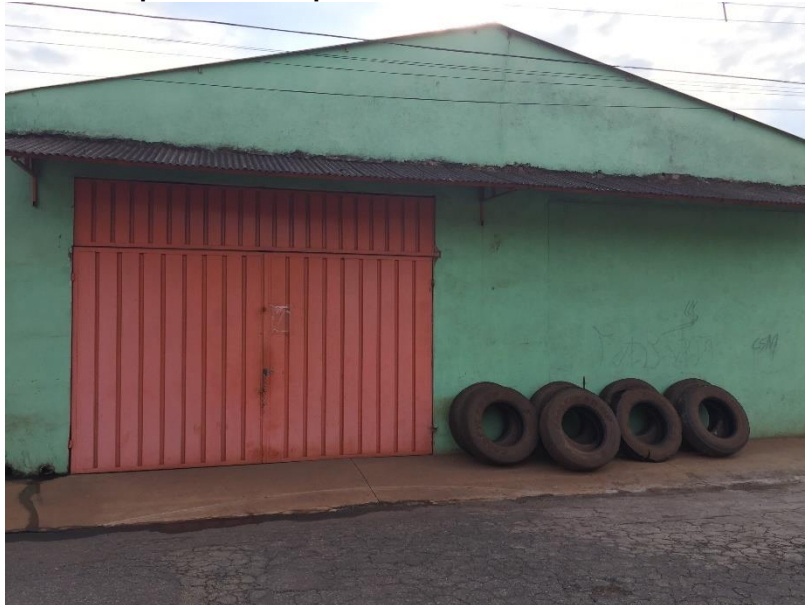
Figura 22: Galpão Utilizado para Armazenamento de Pneus Inservíveis
