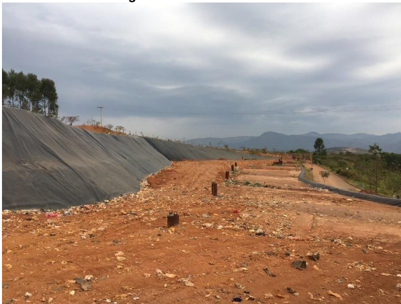
Figura 47: Drenos de Gases
