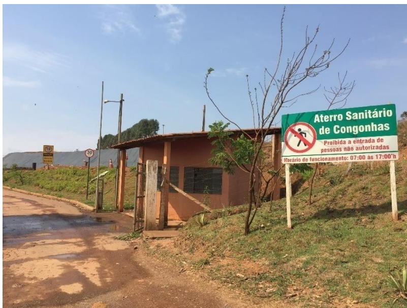
Figura 45: Portão de Acesso ao Aterro Municipal
