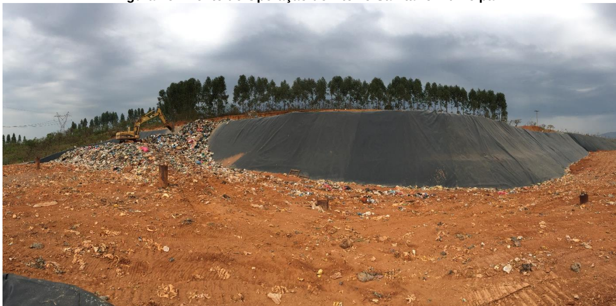
Figura 46: Frente de Operação do Aterro Sanitário Municipal
