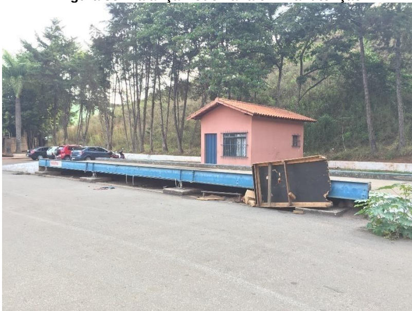
Figura 35: Balança Rodoviária em Manutenção
