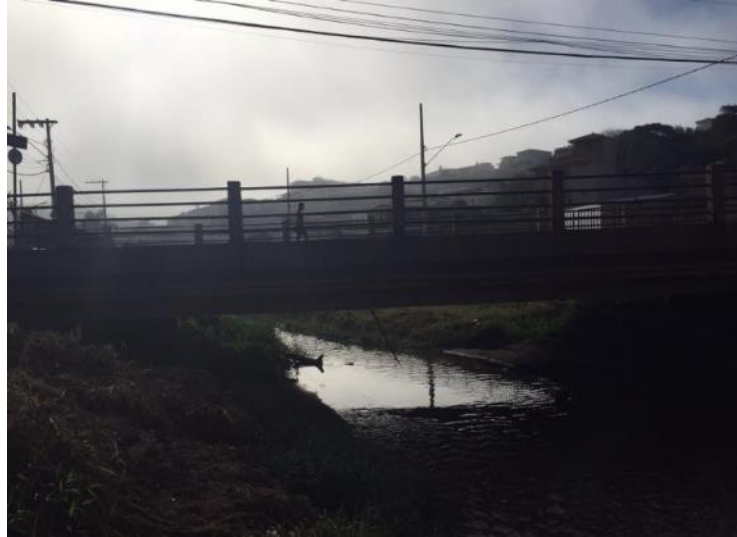
Figura 110: Ponte sobre o Rio Santo Antônio
