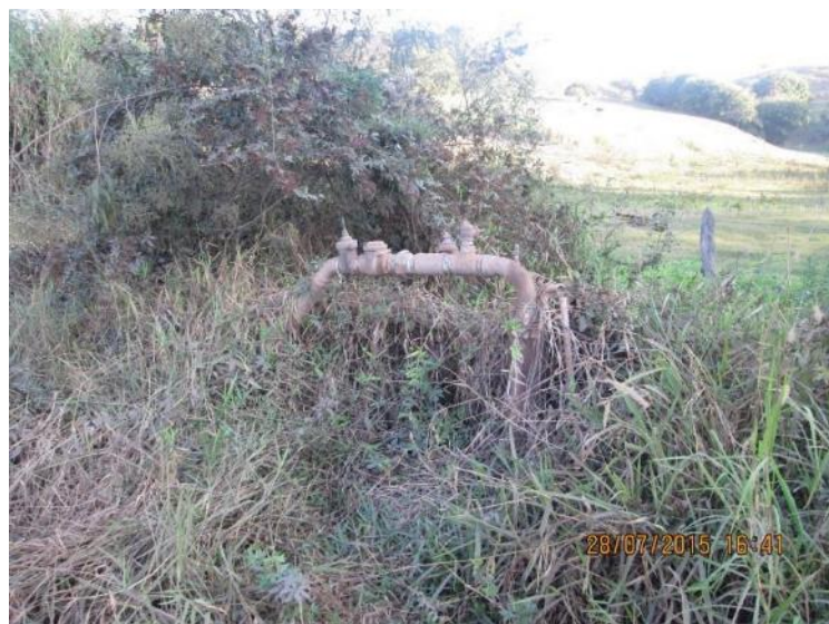
Figura 60 – Poço Localidade de Pequeri
