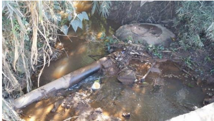
Figura 71 – Interceptor sob a ponte do Rio Maranhão - Recebe efluente da R. Profeta Isaías e R. Pia André
