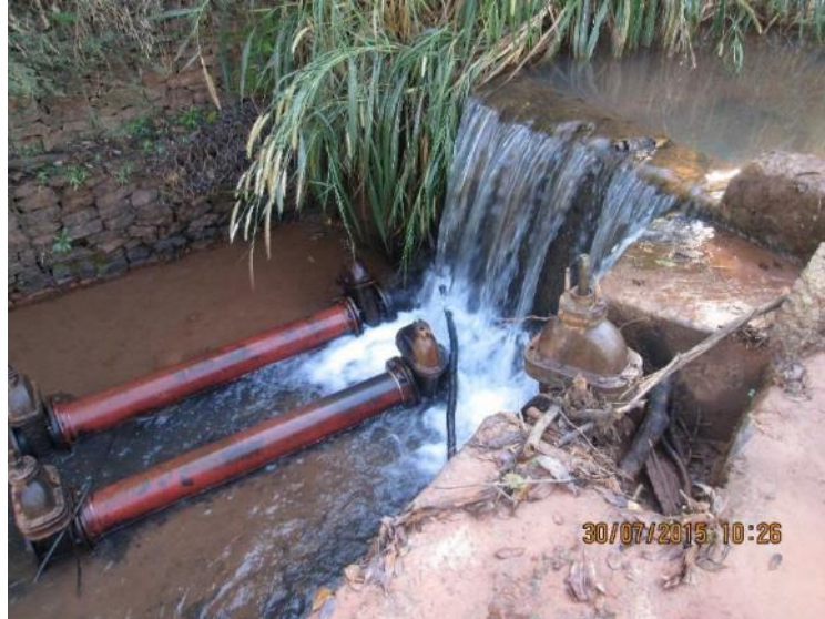
Figura 35 - Captação barragem Córrego Macaquinho
