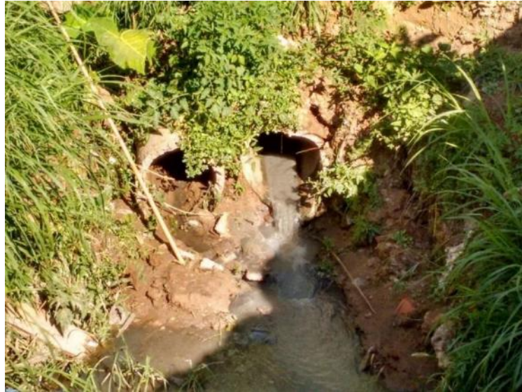
Figura 82 - Lançamento da rede coletora do Bairro Alvorada
