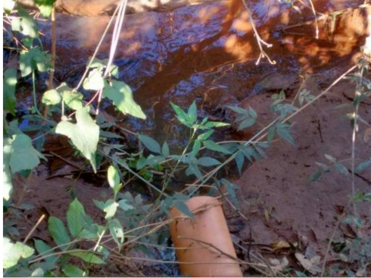
Figura 78 – Lançamento de esgoto proveniente do Bairro Alvorada
