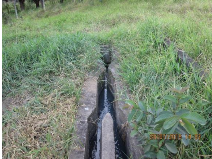
Figura 86 – Fase de tratamento preliminar da ETE
