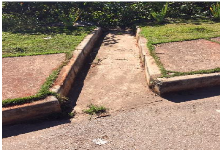
Figura 114: Canaleta de drenagem
