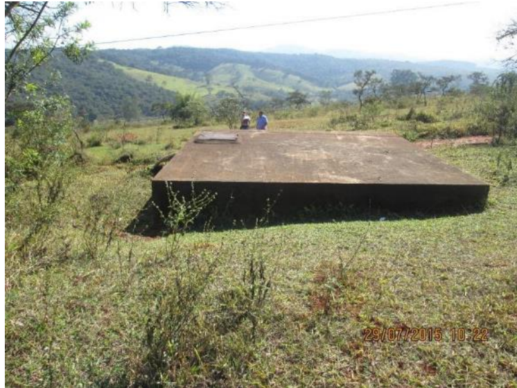
Figura 55 – Reservatório Distrito de Lobo Leite
