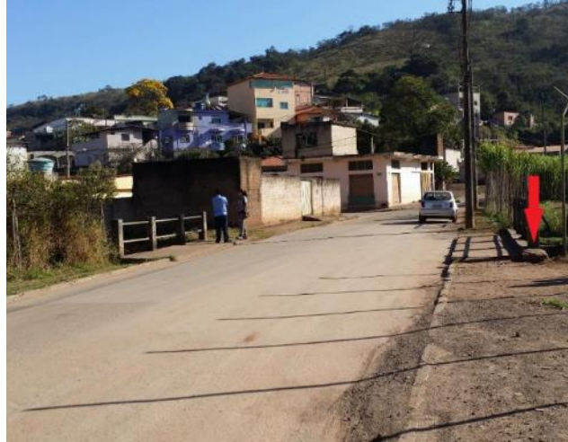
Figura 68 – Interceptor do Córrego Macaquinhos
