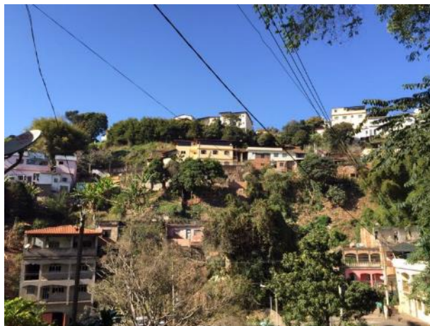
Figura 120: Bairro Bom Jesus - Risco de movimentação em massa
