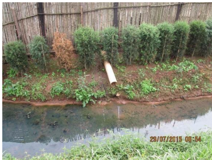
Figura 100 – Lançamento individual no Córrego Várzea da Pedra
