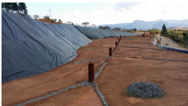
Figura 142 – Área do Aterro Sanitário que será utilizado futuramente
