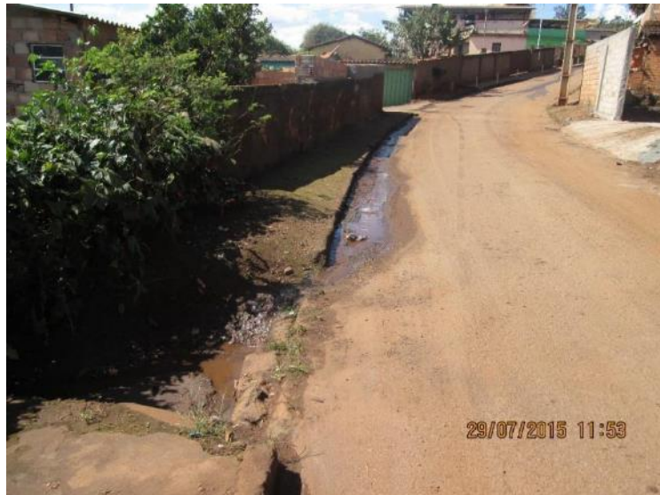
Figura 104 – Esgoto sendo lançado a céu aberto
