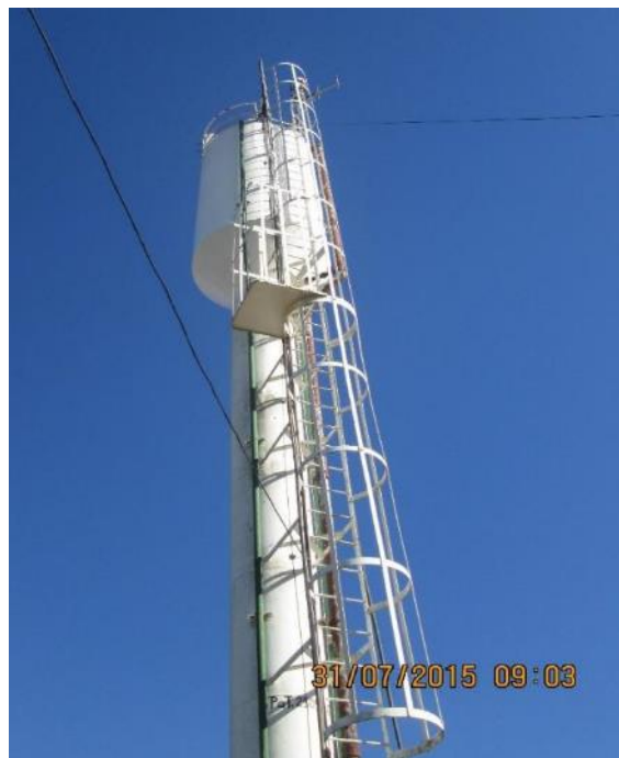
Figura 34 – Reservatório elevado Vila Rica
