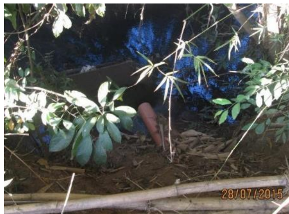
Figura 94 – Lançamento da rede coletora de esgotos no Rio Pequeri
