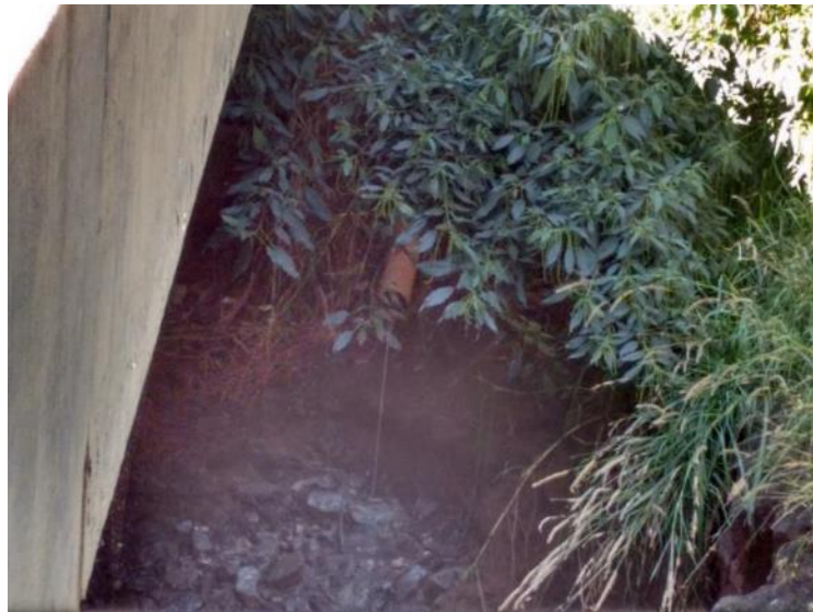
Figura 81 - Lançamento de esgoto no Córrego Santo Antônio, proveniente do bairro Campinho
