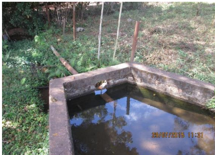
Figura 64 –Captação Córrego Pires II
