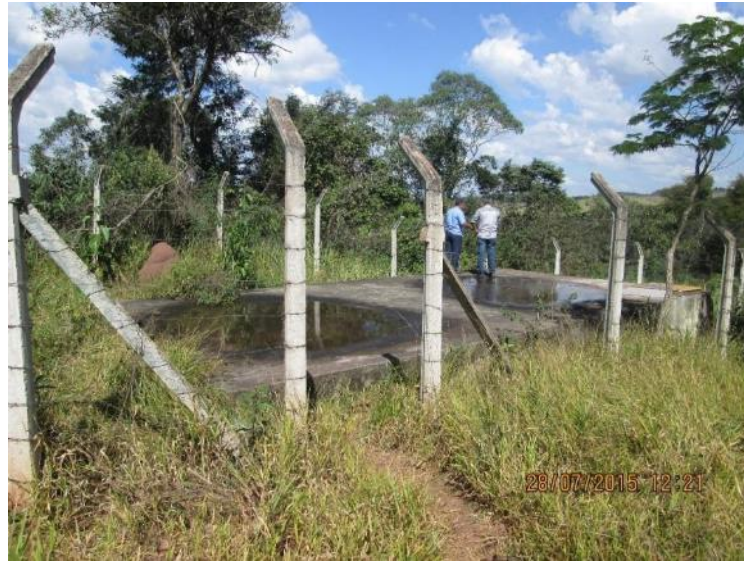
Figura 59 – Reservatório Localidade de Santa Quitéria
