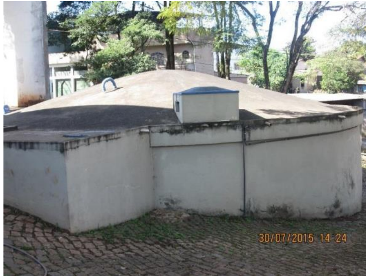
Figura 24 – Reservatório semi enterrado
