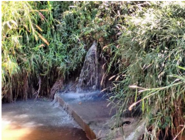
Figura 79 - Lançamento de esgoto no Córrego Goiabeira proveniente da R. Zé Loureiro
