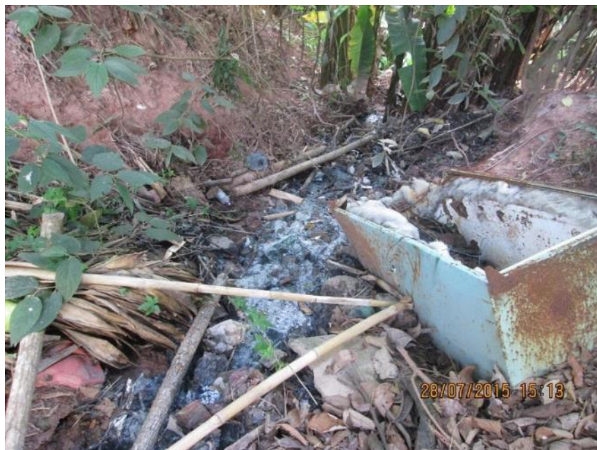
Figura 88 – Fossa extravasando
