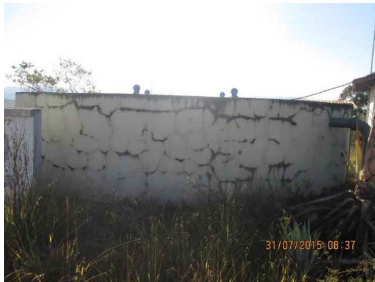
Figura 30 - Reservatório Cruzeiro Semi enterrado
