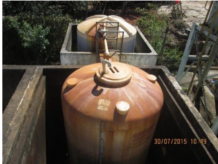
Figura 41 – Armazenamento de solução de Hipoclorito de Cálcio e de Ácido Fluossilícico
