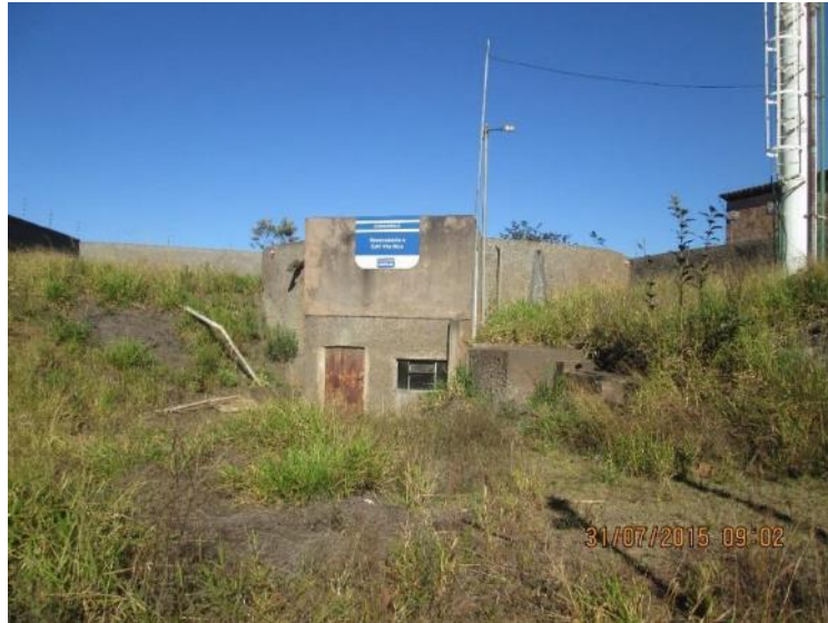
Figura 33 – Reservatório semi enterrado e Estação elevatória Vila Rica
