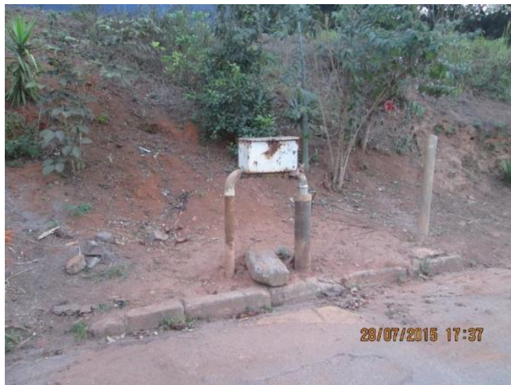
Figura 66 - Poço Localidade de Vila José Marques
