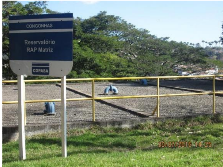
Figura 27 – Reservatório Apoiado de 1650 m 3
