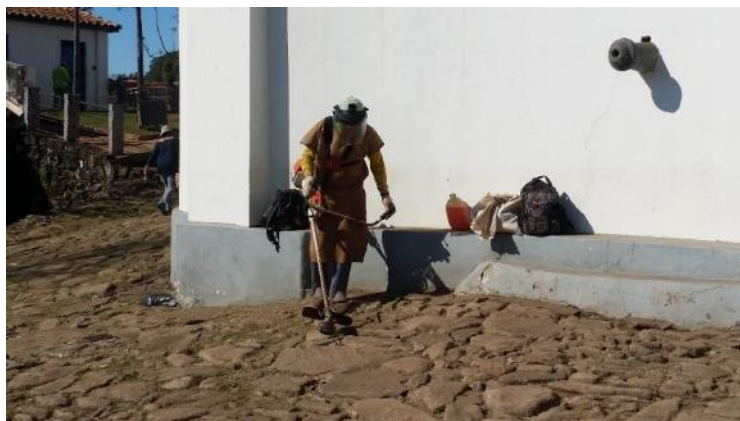
Figura 131 - Realização do serviço de roçada
