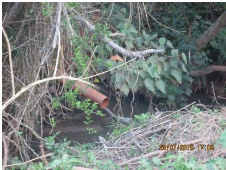
Figura 96 – Ponto de lançamento da rede coletora separadora - Vila Cardoso
