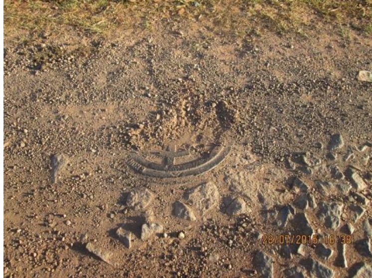
Figura 95 – Poço de visita da rede coletora separadora em Pequeri
