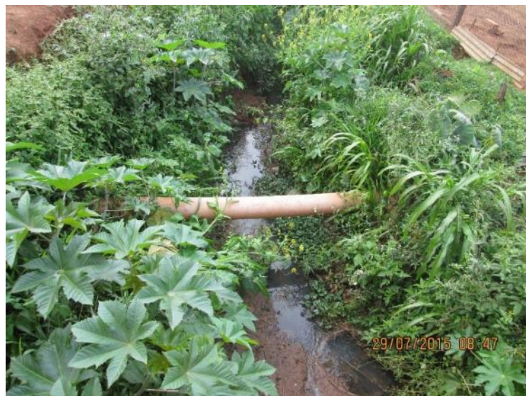
Figura 98 – Interceptor atravessando a R. Dom Oscar de Oliveira - lançamento no Rio Maranhão
