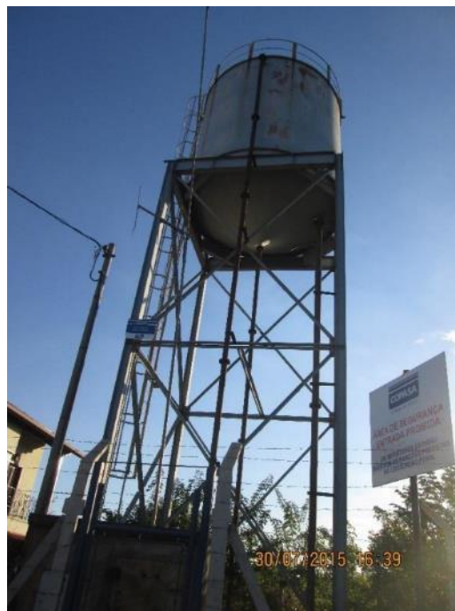
Figura 28 –Reservatório Casa de Pedra
