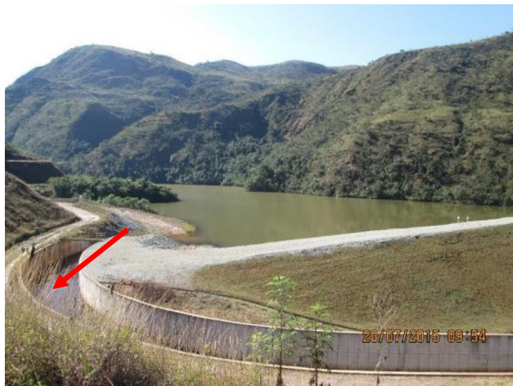
Figura 56 – Captação no Córrego de Esmeril
