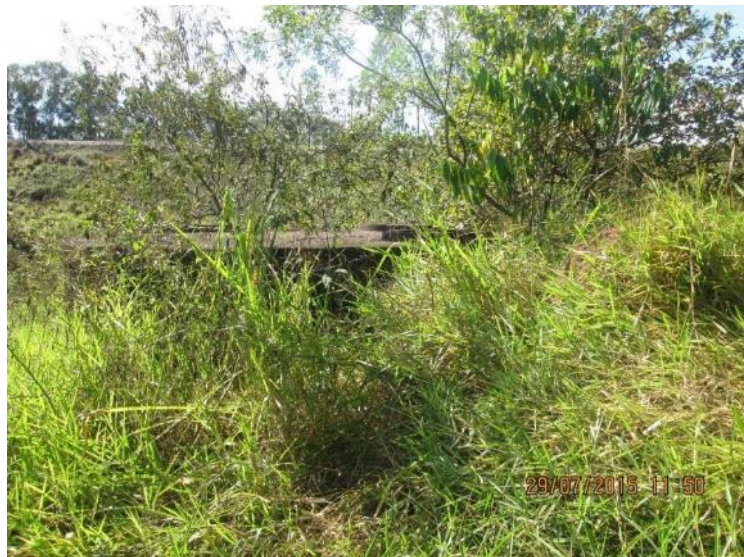
Figura 102 – Estação de Tratamento de Esgoto I - Pires
